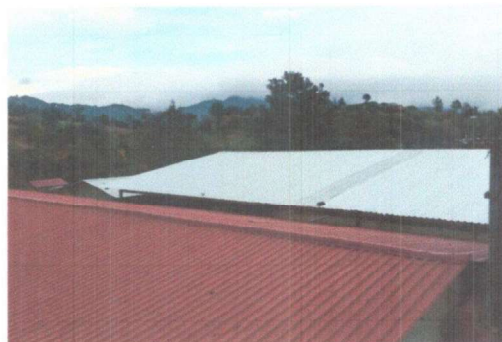
Foto 2: Cubierta de lamina
